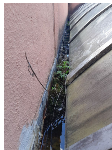
Chéneau latéral sur la zone couverte en polycarbonate ( impossibilité actuelle d'entretien)
