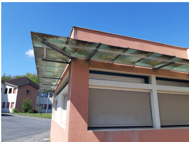
Zone d'entrée (brise-soleils en polycarbonate) zone couverte sur entrée
